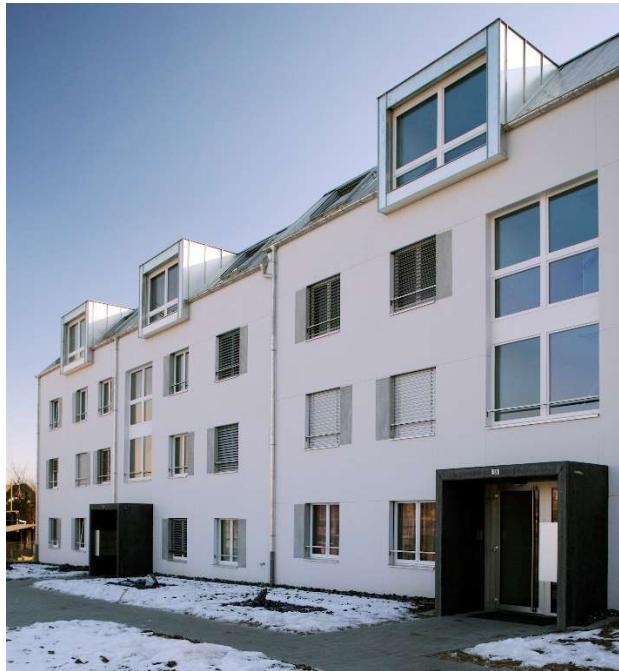
Projekt Mehrfamilienhaus «Morgentalstrasse 13/15», Dällikon Vorfabrizierte Dachlukarnen mit Blechverkleidung, Betonschrägdach mit PU-Isolation und Blechverkleidung
