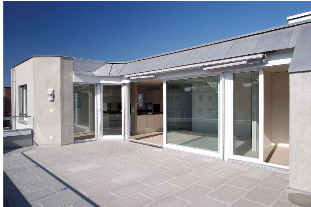
Projekt Mehrfamilienhaus «Morgentalstrasse 13/15», Dällikon Vorfabrizierte Dachlukarnen mit Blechverkleidung, Betonschrägdach mit PU-Isolation und Blechverkleidung
