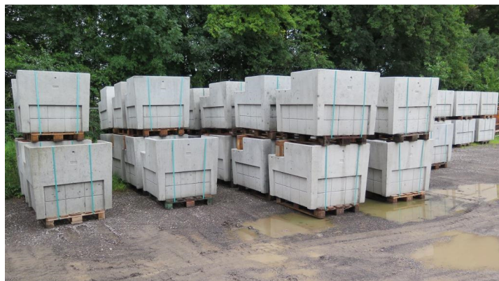
Oben: Kabelschächte für Pistenneubau Flughafen Zürich
