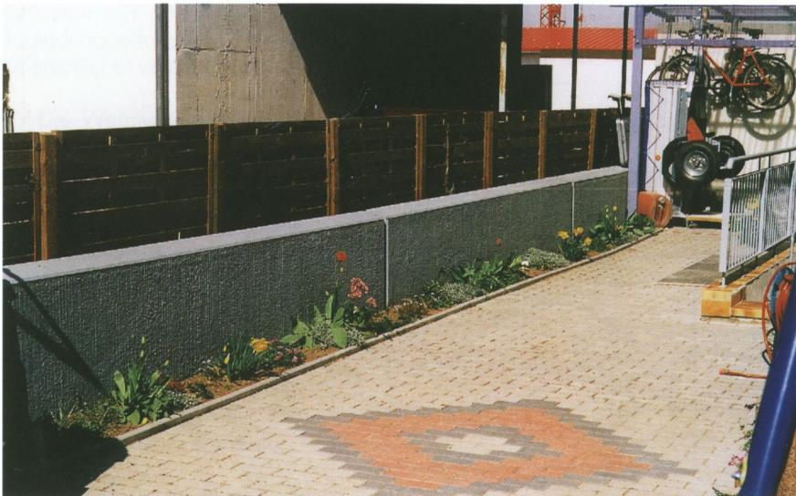
**Bild 3: Gartenmauer als Massivabsorber**
