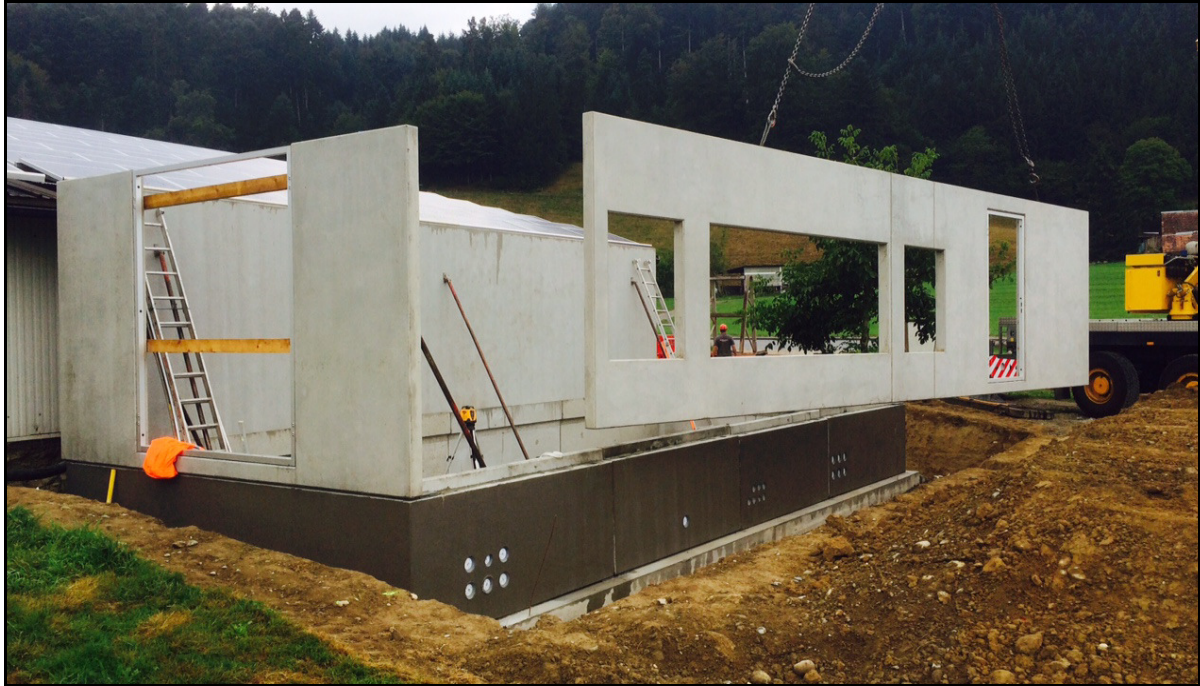
Bild oben: Frontfassade mit Aussparungen. Am Stück betoniert. Gewicht: 6.5 to
