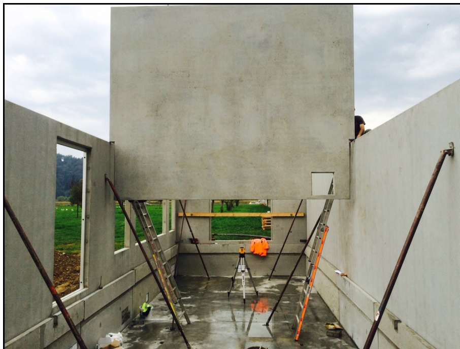
Bild oben: Frontfassade mit Aussparungen. Am Stück betoniert. Gewicht: 6.5 to
