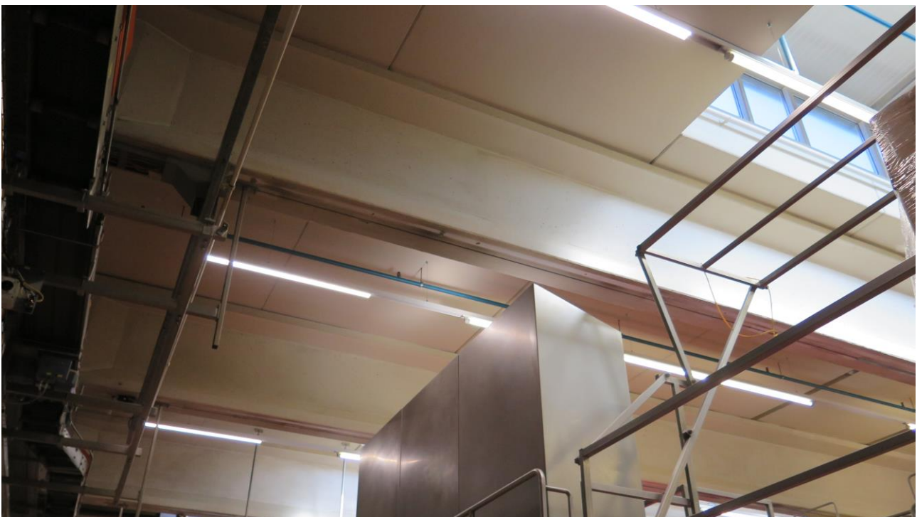
Oben: Vorfabrizierte Randträger und Seitenwände aus Beton Unten: Innenaufnahme der Deckenträger, darunter stehen Produktions- und Verpackungsanlagen
