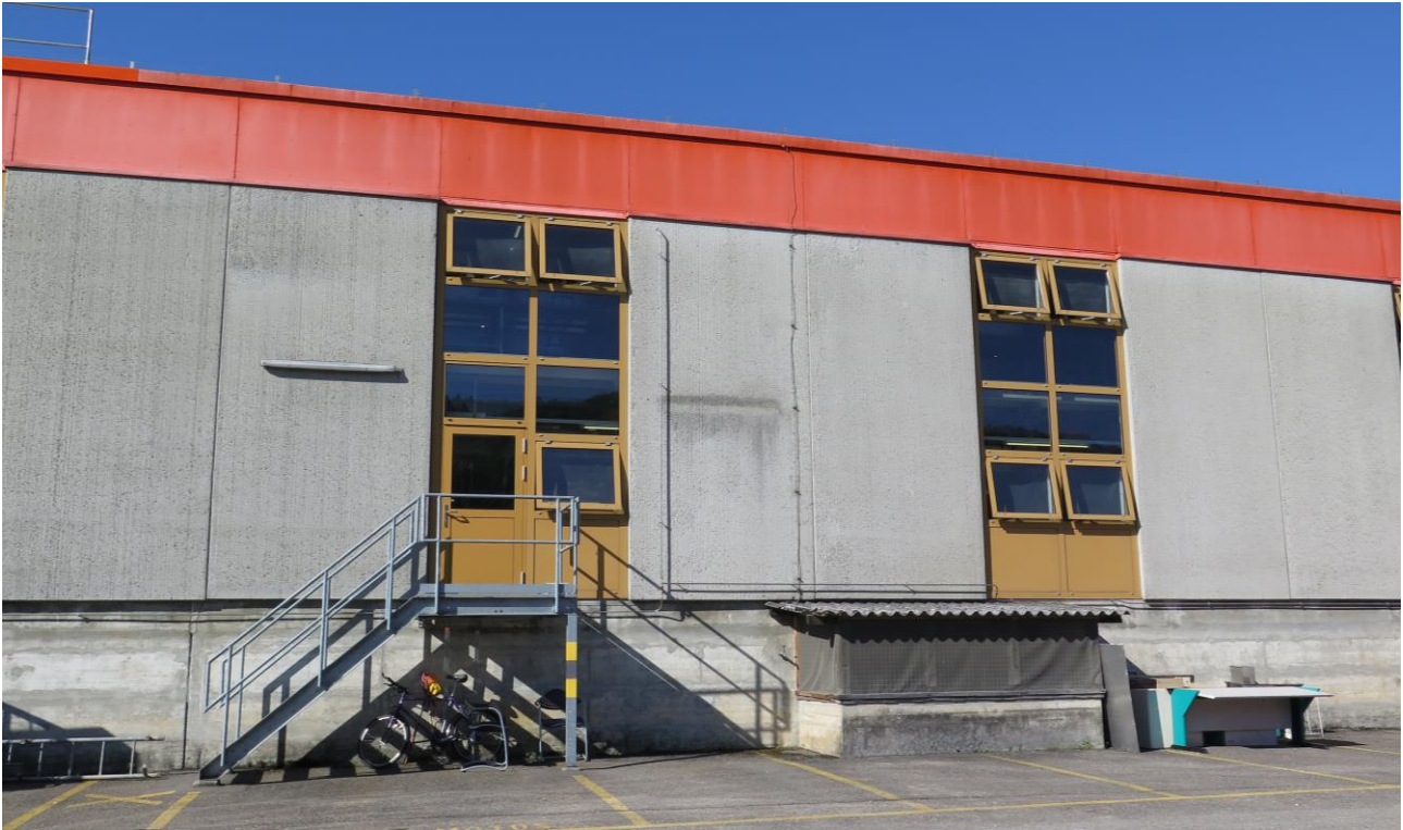
Oben: Vorfabrizierte Randträger und Seitenwände aus Beton Unten: Innenaufnahme der Deckenträger, darunter stehen Produktions- und Verpackungsanlagen
