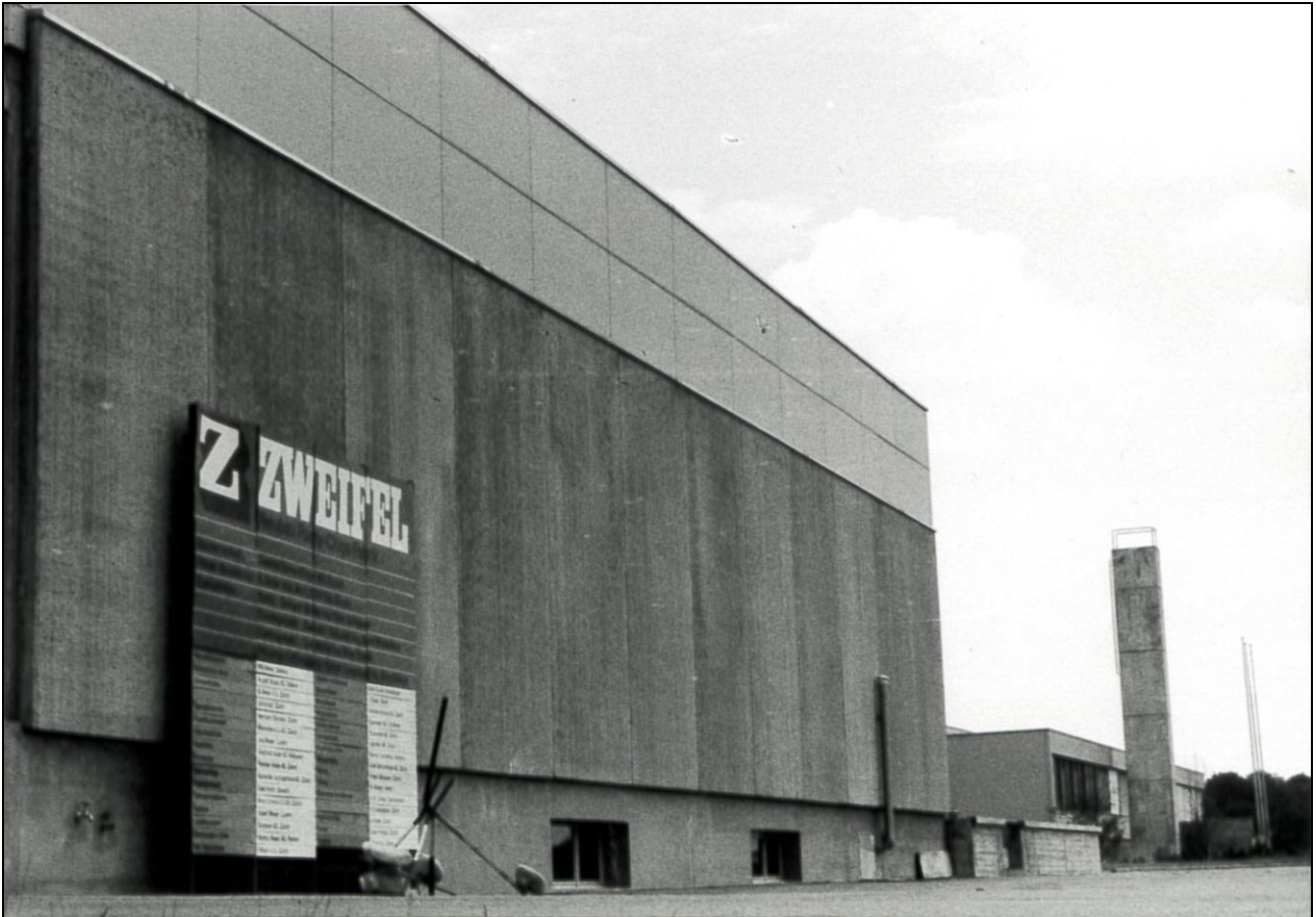
Aufnahme der fertiggestellten Produktionshalle 1969
