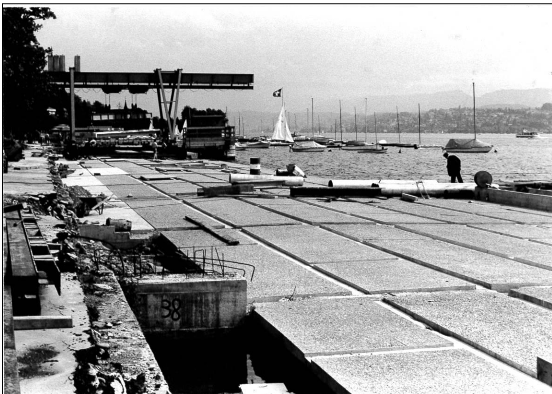
Setzung der vorfabrizierten Abdeckplatten mittels mobilem Kran (Aufnahmedatum:1970). Dieser Kran konnte nach Beendigung des Auftrags auf dem Werkhof Dällikon installiert werden. Bis heute verrichtet er zuverlässig seinen Dienst.
