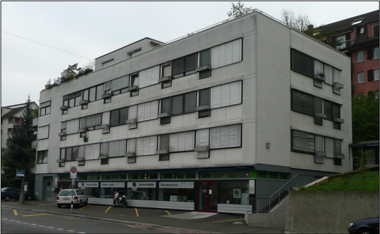
Foto vor der Sanierung der Fassade
