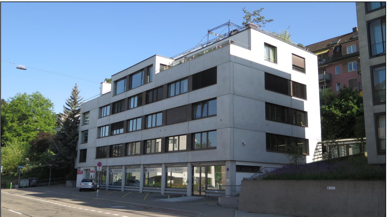
Fertiges Gebäude nach der Fassadensanierung
