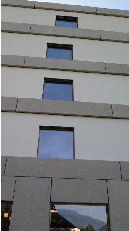
Oberflächen Fassadenelemente: teils schalungsglatt, teils sandgestrahlt.
