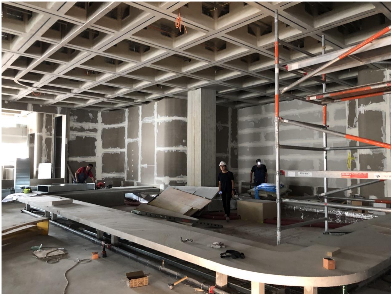
Betonelemente im installierten Zustand während der Bauphase
