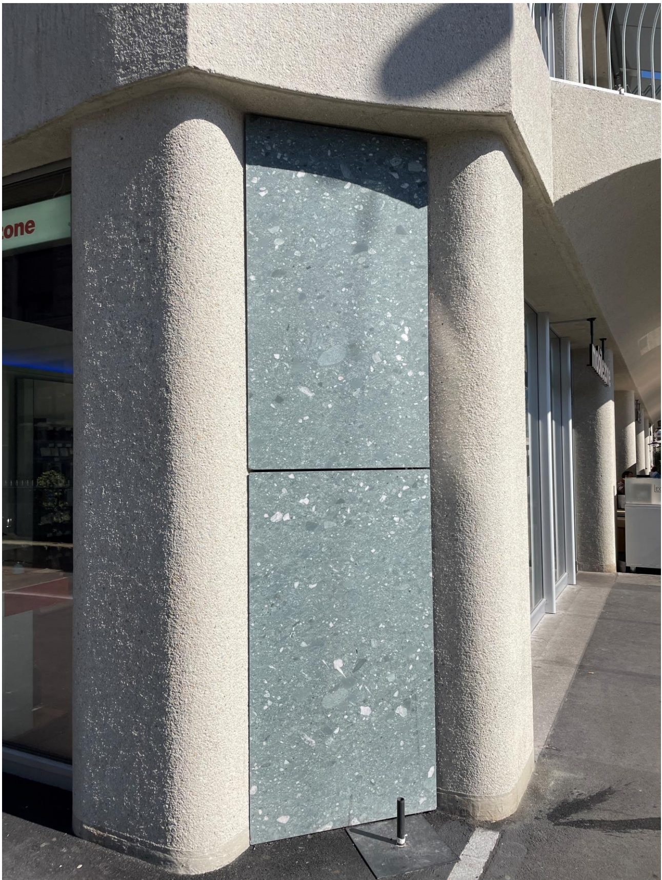
Die vorgefabrizierten Betonstützen umschliessen die grünen Natursteinplatten.
